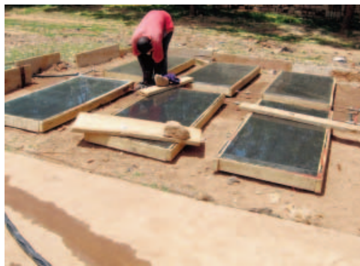
Construction d'un four.
