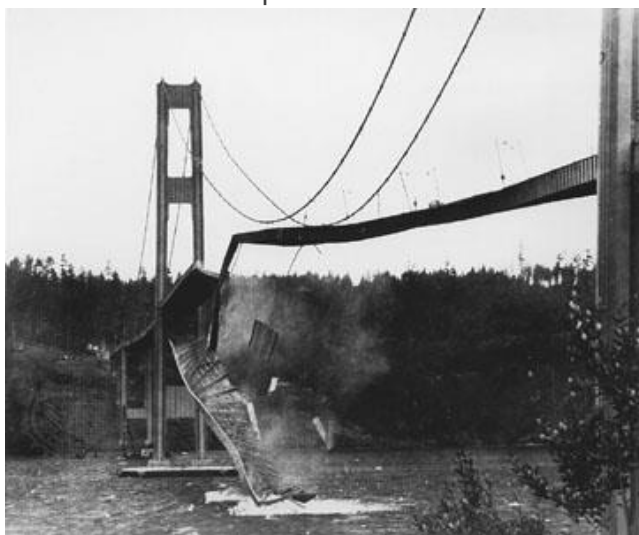
Figure 1 : Effondrement du pont de Takoma (1940). Source : Wikipedia
