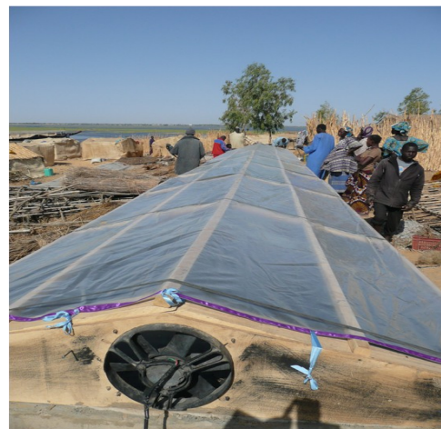
Installation d'un séchoir à poisson Photo C. Heilporn
